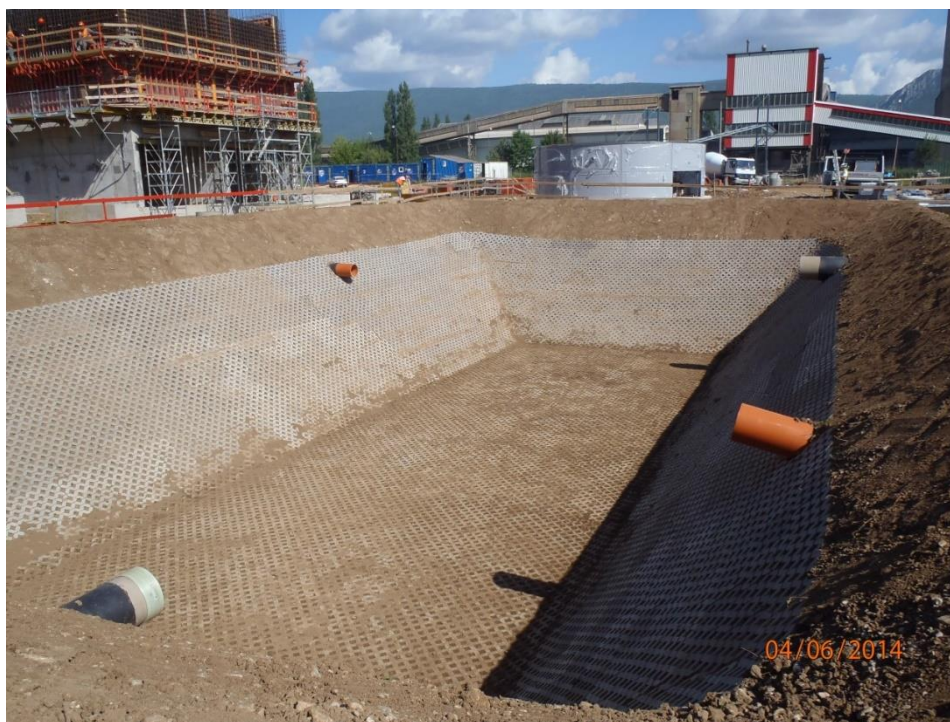
Obrázok č. 11: Existujúca retenčná nádrž v areáli skladu tuhých alternatívnych palív „TAP 200“
